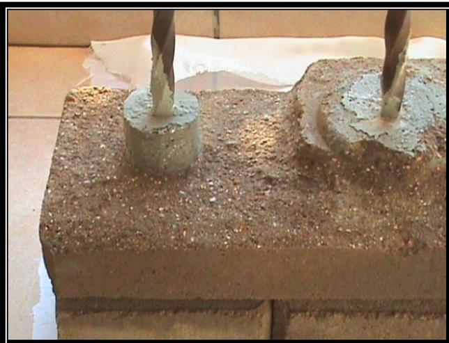
**Facultatif- Pour sécuriser les murs, on introduit une barre d'armature dans les tubes adjacents, puis on y coule du ciment.**
