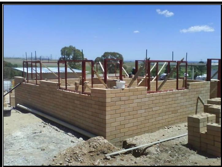
**Une fois les ouvertures installées, on continue à poser les rangs de briques STABI pour édifier les murs.**
