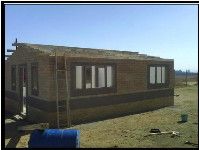
Le toit est construit de manière traditionnelle avec des poutres. Ces dernières sont posées sur les briques, perpendiculairement. En cas d'écart de jeu, on peut effectuer un rattrapage au mortier de scellement (*sable et ciment mélangé à de l'eau*).
