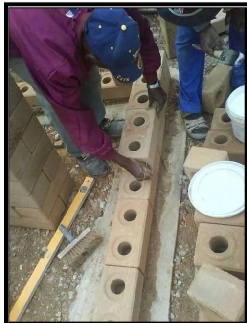
**La fondation doit être coulée à niveau avec du mortier de ciment dans la fouille.**
