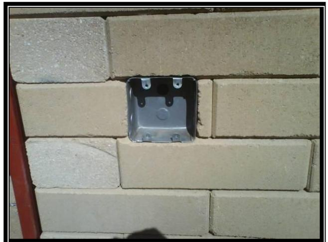
Les câbles électriques sont montés dans un tube lors du perçage de trous pilotes. Le tube se pose vers le bas. La boîte est ensuite posée après la pose des câbles.
