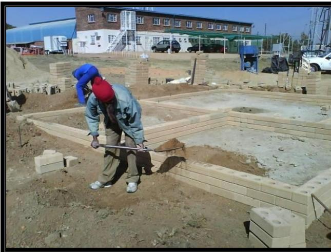
Les fondations peuvent désormais être remblayées et le remblai compacté. Les tubes formés par les trous des STABI sont alors remplis avec un maigre béton semi liquide. Les murs de la fondation sont alors en place. Les tubes formés par les trous des briques STABI au niveau des parois internes sont également remplis de béton. On coule une dalle standard entre les fondations sur le remblai compressé.
