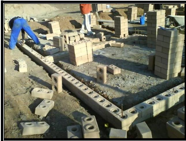
En superposant de façon décalée les briques dans les angles et en reliant les parois internes aux murs extérieurs la structure, la structure sera très résistante. Elle sera plus solide qu'une structure de briques traditionnelles. La bonne technique consiste à construire les rangs de briques d'une manière circulaire, d'une extrémité à l'autre. En raison de la régularité de la brique, il est déconseillé d'élever les murs en commençant simultanément en plusieurs endroits.
