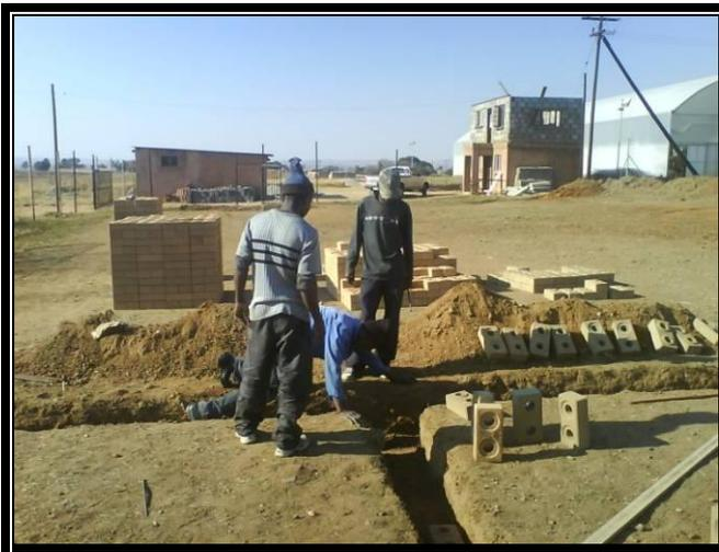
C'est une façon traditionnelle de construire avec le mur de fondation sur le pourtour ainsi qu'à la base des cloisons.
