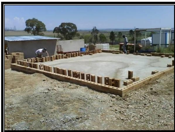
En fonction de la structure en cours de construction, on peut aussi construire uniquement un mur sur le périmètre (sans socle de cloisons) et coulage d'une dalle à l'intérieur. Une dalle de 150 mm d'épaisseur est coulée entre les murs.
